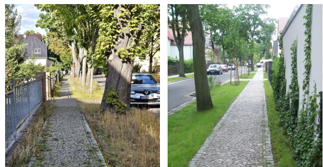
Bilder 12 und 13: Versickerungsgrün bringt leichte Verwilderung unterhalb der Bäume (links) mit Selbstdüngung durch Verwitterung der Grünmasse. Im Frühjahr und bei ausreichendem Regen sieht es besser, weil grün aus (rechts).
