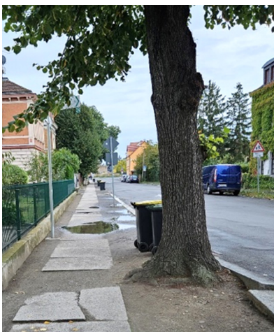
Bild 7: Historischer Seitenraum mit Gehbahn und unversiegeltem Ober- und Unterstreifen
